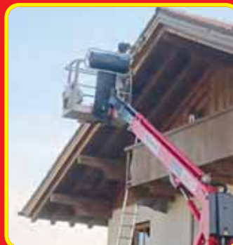
Holz anstrich mit Arbeitsbühne
