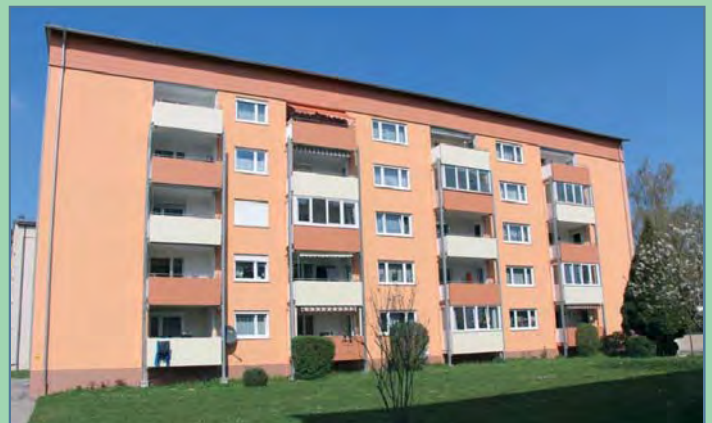
verwaltete Wohnanlage an der Pienzenauer Str. 7/9, Erstbezug 1965/1966, 20 Einheiten
