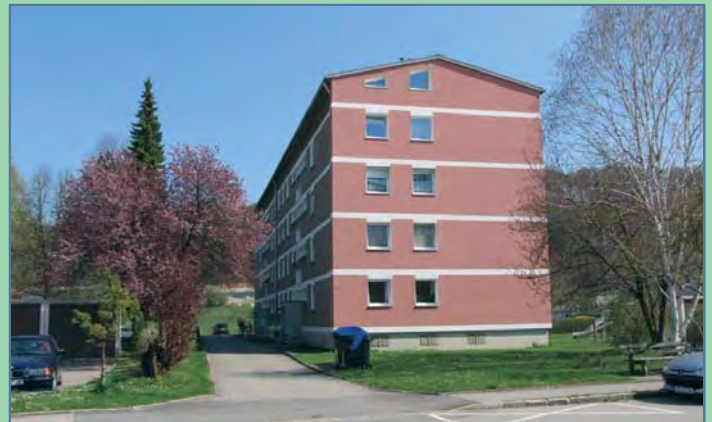
Wohnanlage an der Pienzenauer Str. 6/8, Baujahr 1966, 20 Einheiten, davon 8 verwaltet
